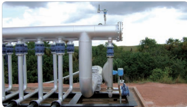
Obr. 5 Prístroje na meranie tlaku a prietoku s WirelessHART umožňujú monitorovať výkon ropného vrtu
