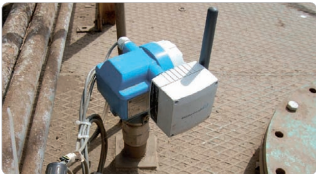
Obr. 2 Prevádzkový prístroj s adaptérom WirelessHART na vzdialenom a ťažko dostupnom mieste
