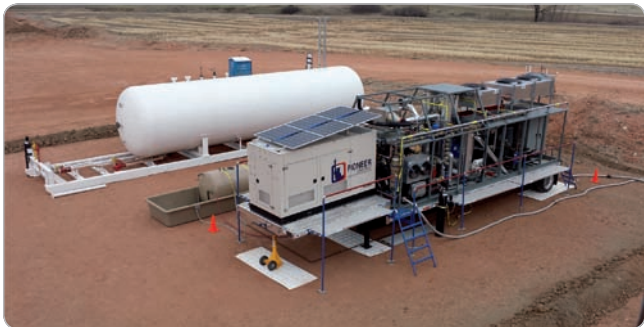
Obr. Systém MAGS pri jednom z vrtov v Severnej Dakote
